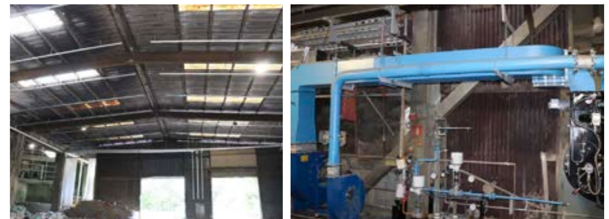
Sprinklage hall fosse
