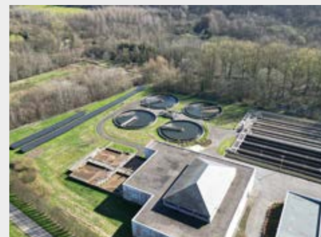
Station d'épuration de la Vallée de la Lasne
