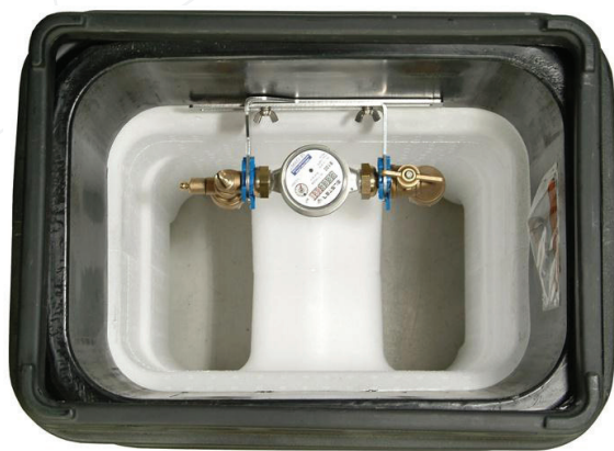
Vue de l'intérieur de la loge
